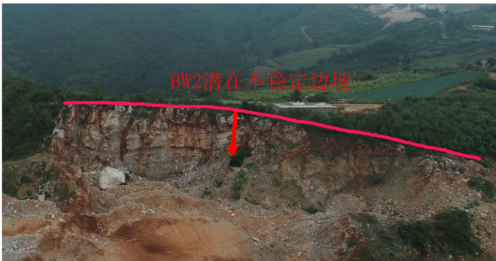
照片3-2 潜在不稳定边坡BW2现状
