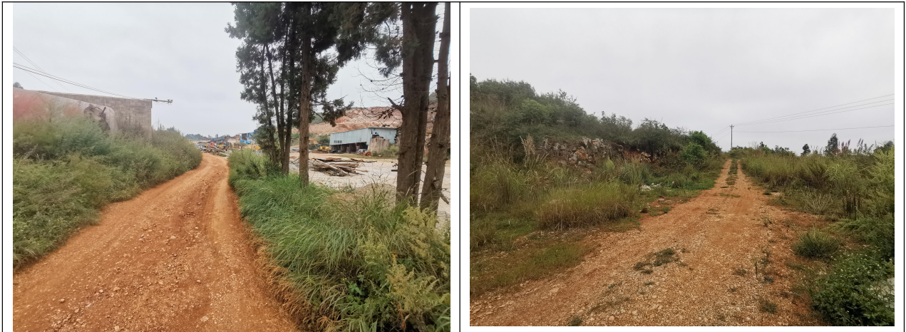
照片 3-9 评估区公路（乡村公路）
